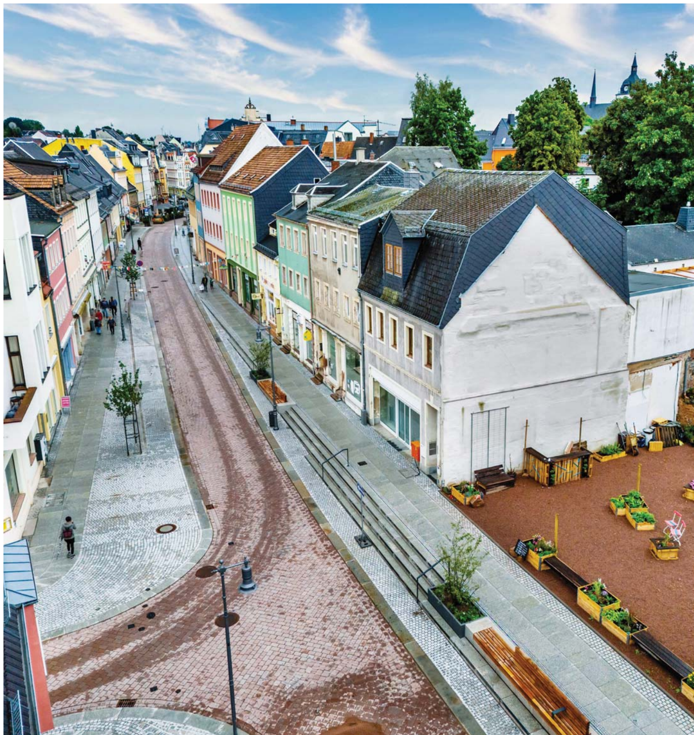
Fertigstellung 1. Bauabschnitt 2022 | Foto: Christian Leuschner
